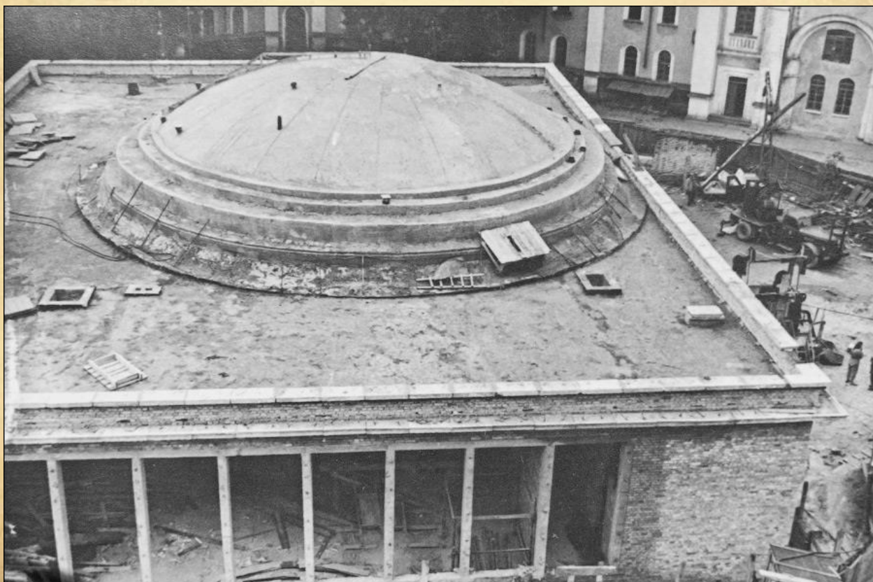
Будівництво вестибюля наближається до завершення.
