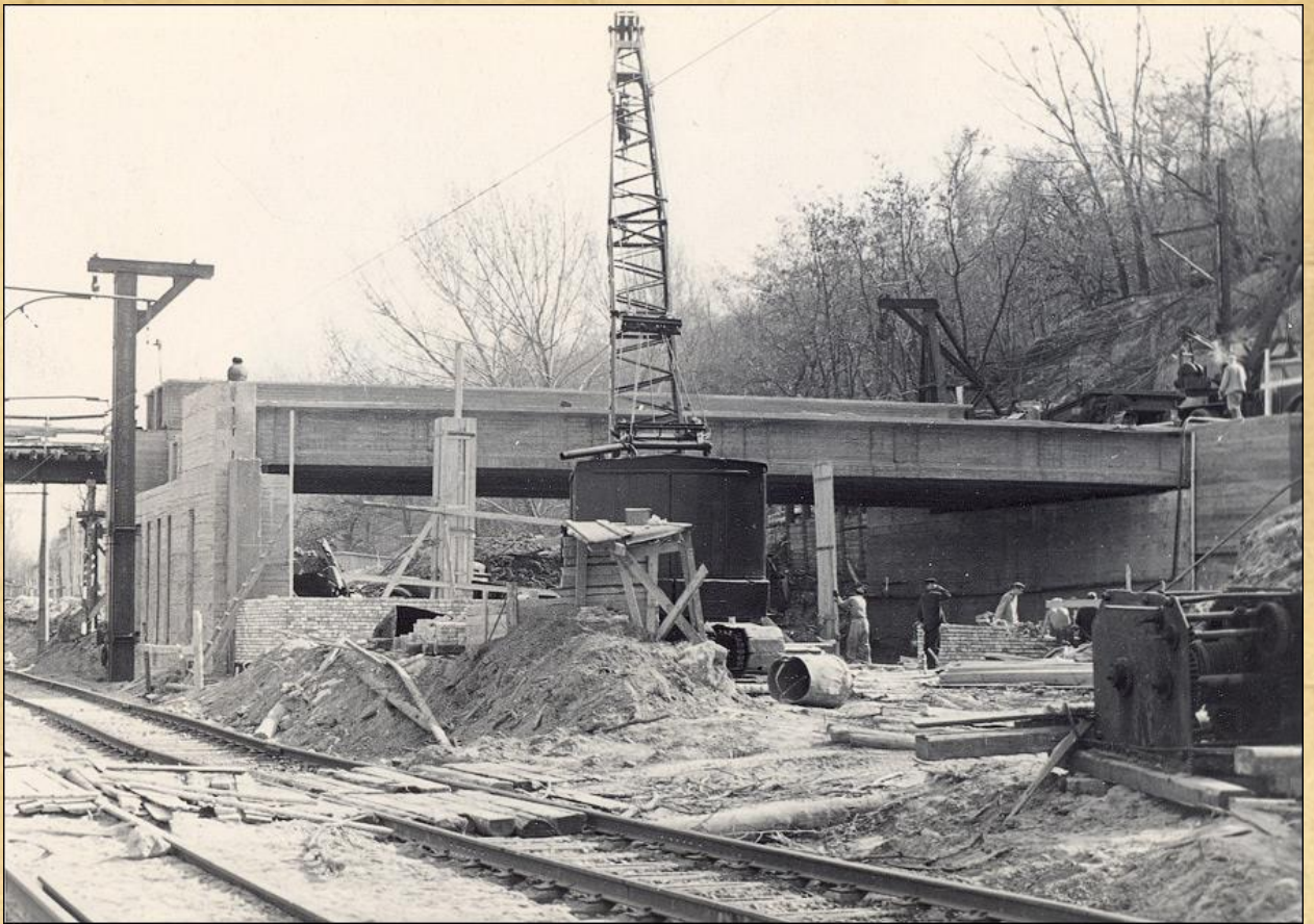
Майбутній вестибюль станції.
