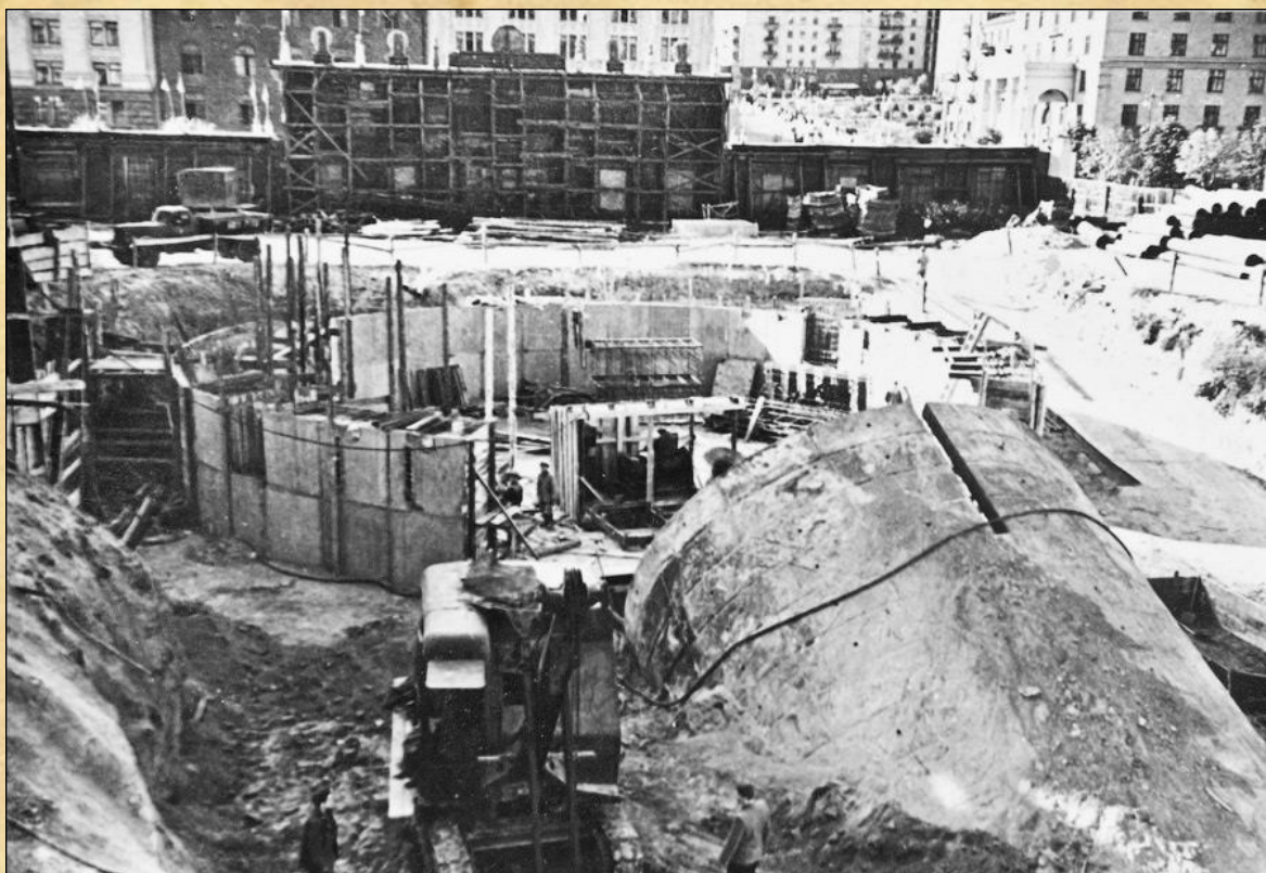
Проломку похилого ходу завершено, естакаду розібрано і розпочато складання циліндричного ескалаторного залу.
