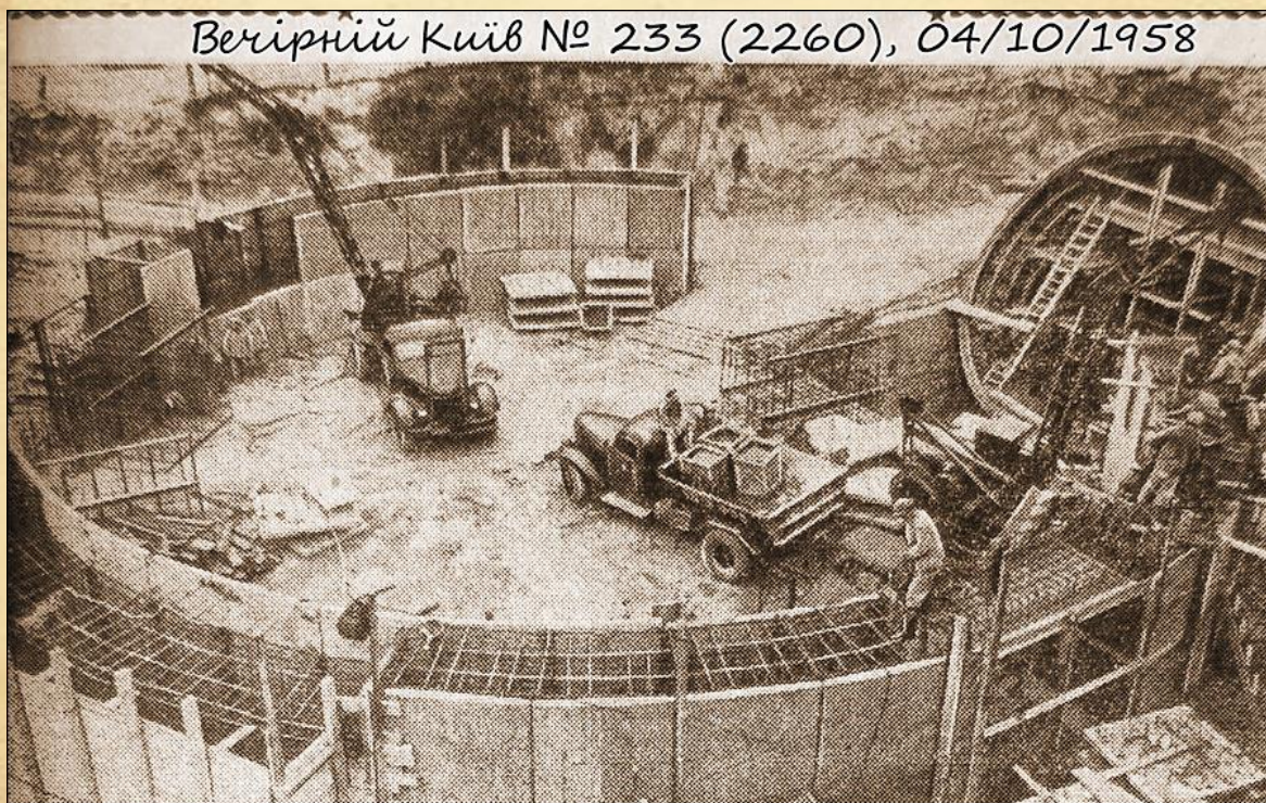
Будівництво ескалаторного залу основного вестибюля (вул. Хрещатик). Праворуч похилий хід, ліворуч майбутні проходи з касового залу.
