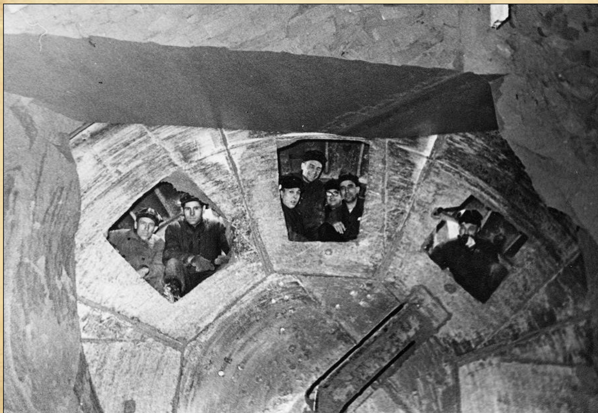
Сбойка. На фото т.зв. "київський" прохідницький щит.
