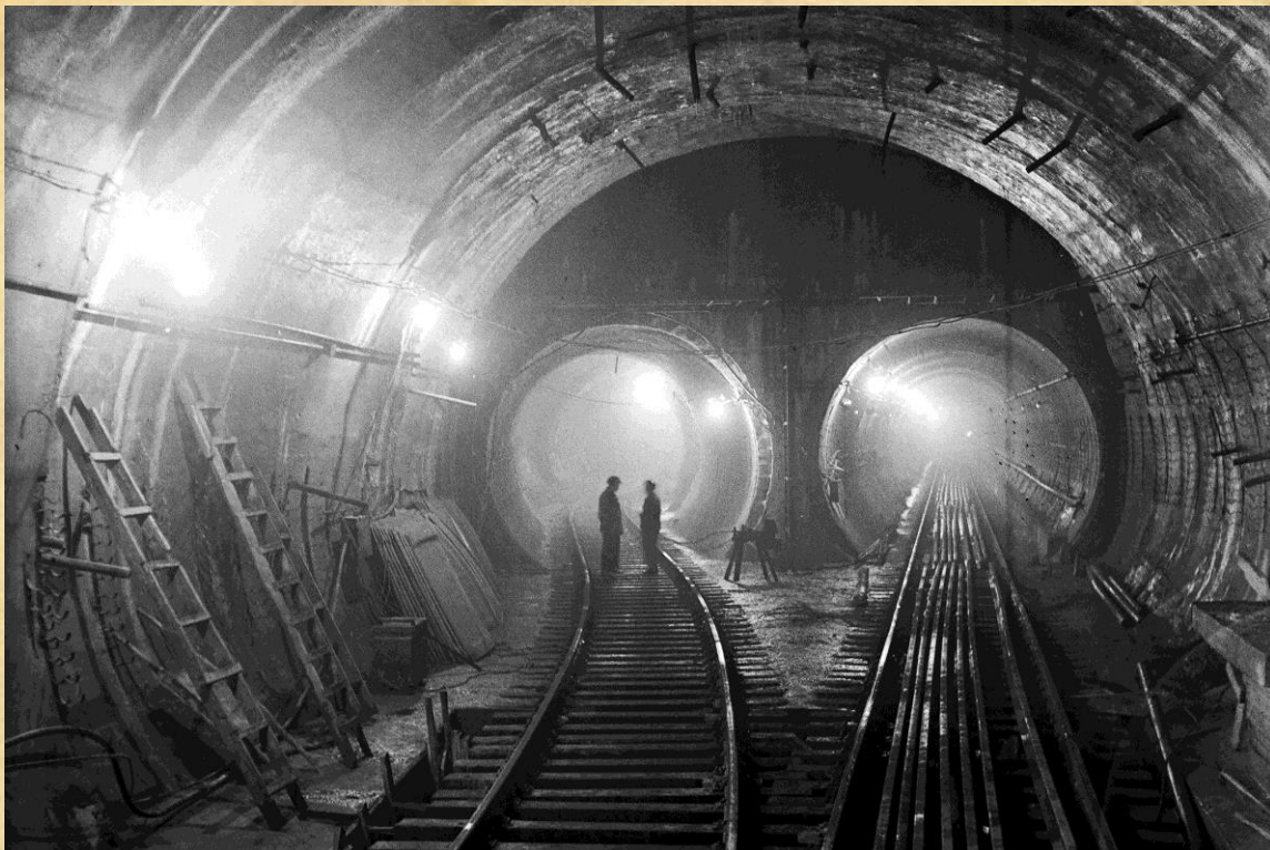
Будівельники Київського метрополітену вивіряють колії в тунелі між станціями «Університет» та «Хрещатик», 31 жовтня 1959 року.
