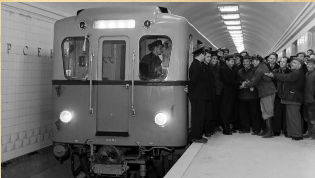
Будівельники Київського метрополітену на станції «Арсенальна» вітають машиніста-інструктора Олексія Сімагіна з першим пробним рейсом, 22 жовтня 1960 року.
