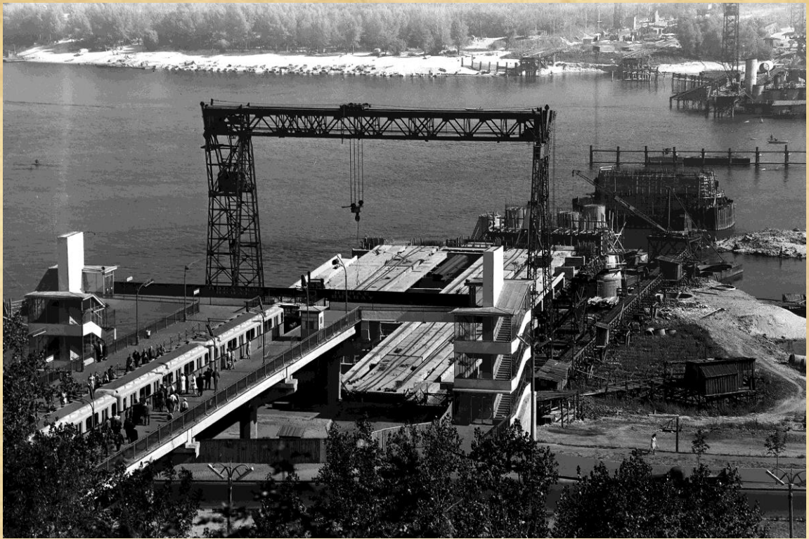
Будівництво лінії Київського метро від станції «Дніпро» на лівий берег, 1963 рік.
