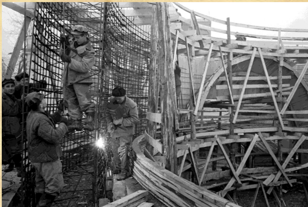
Спорудження підземного проміжного вестибюля станції «Арсенальна» Київського метрополітену, 28 березня 1958 року.
