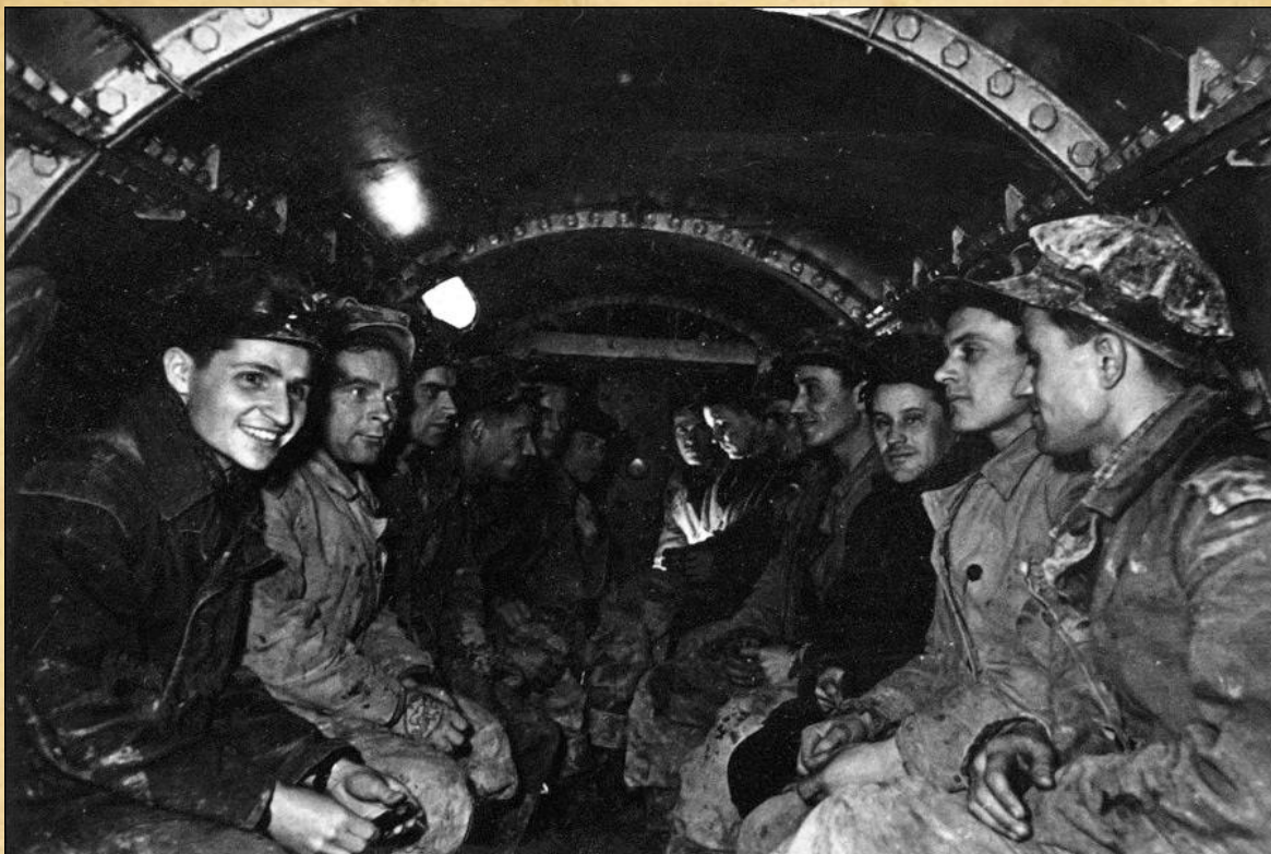
Київська геологія виявилася дуже непростою. Однією з найскладніших ділянок був перегін між "Вокзальною" та "Університетом", де на прохідників чатувало підступне підземне русло Либеді. Крім заморозки ґрунту, для проходки тунелів довелося застосовувати кесон. На фото: кесонна камера.
