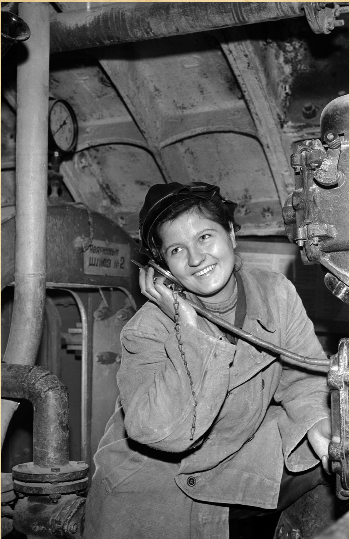
Апаратниця 3-ї ділянки будівництва Київського метрополітену Стеблевська А. за роботою, 31 жовтня 1958 року.
