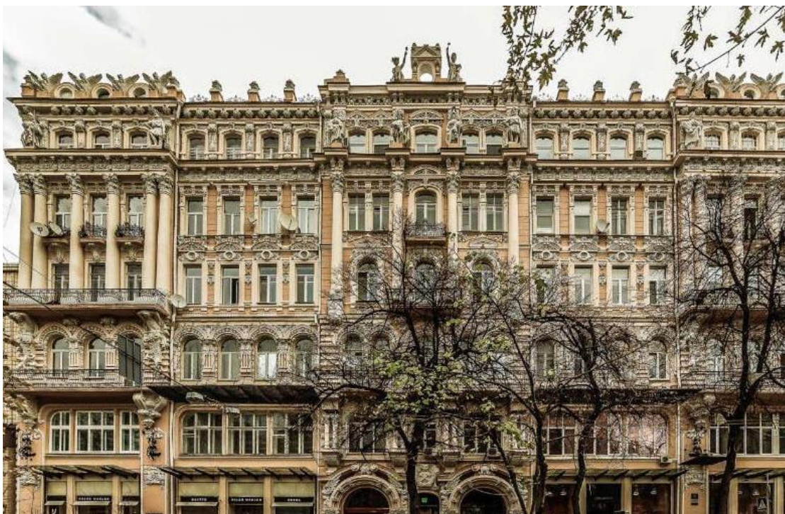
Вулиця Архітектора Городецького, 9. Будинок Гінзбурга
